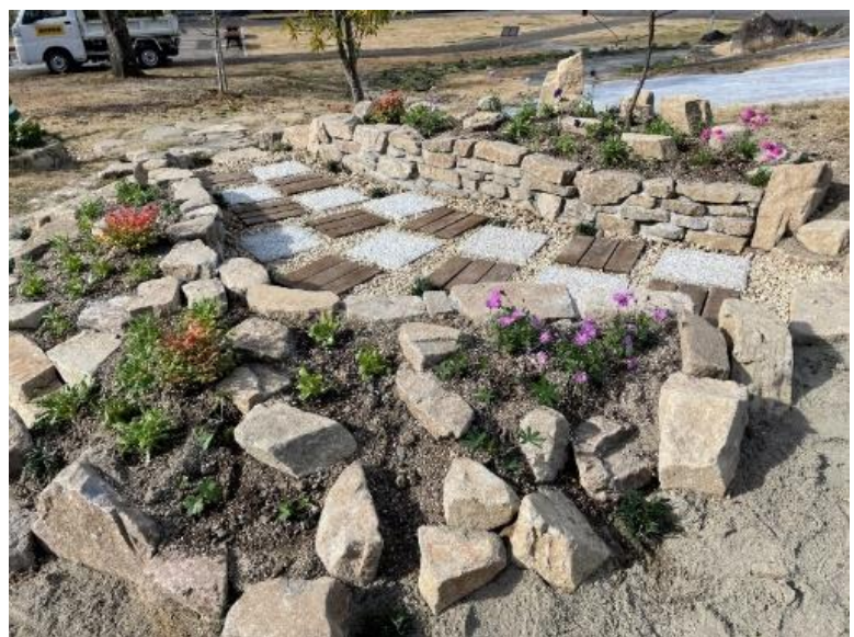
写真－3 完成写真
