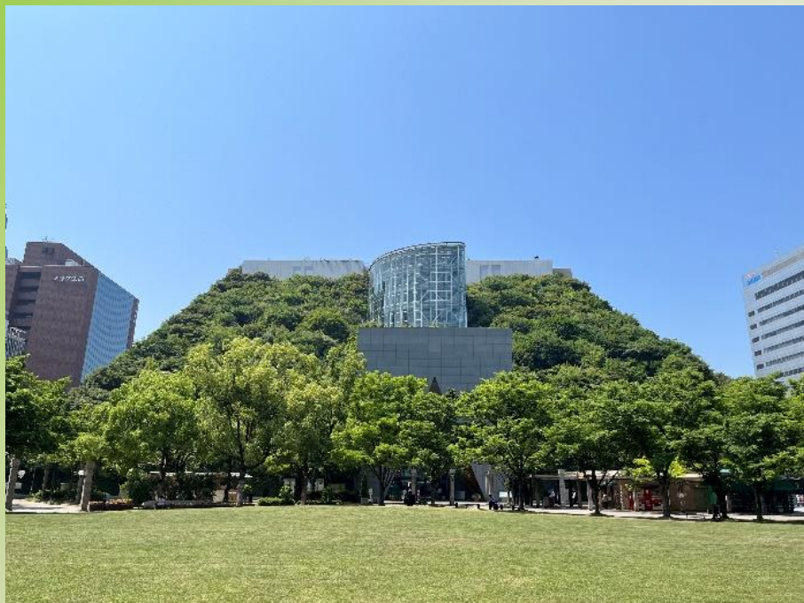
階段状の屋上
